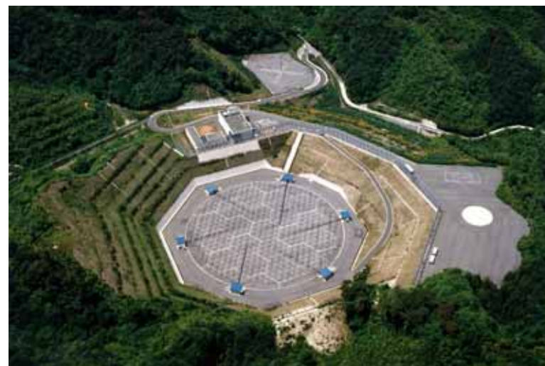
信楽MURレーダー
